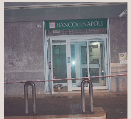
ESPLOSIONE Bancomat preso di mira
