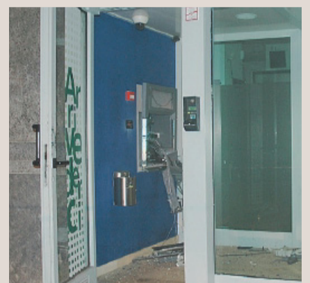
I DANNI In frantumi l'ingresso
